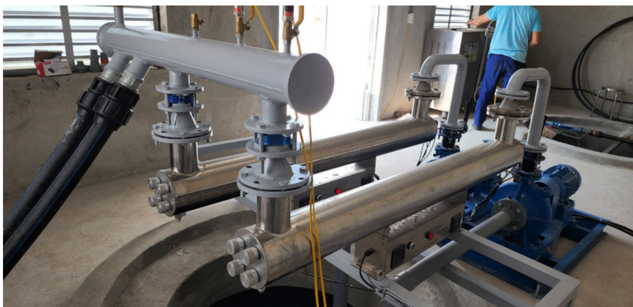
LẮP ĐẶT VÀ HOÀN THIẾT HỆ THỐNG UV VÀ OZONE XỬ LÝ NƯỚC THẢI TẠI HÀ TĨNH
